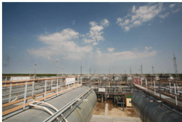
Пуровский завод по переработке конденсата
