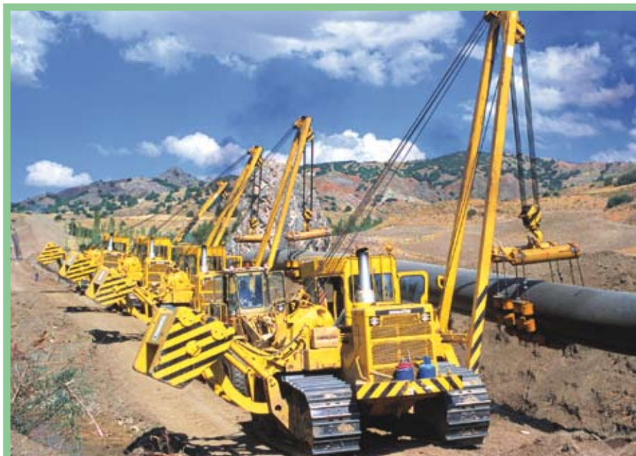
Строительство сухопутной части магистрального газопровода “Голубой поток”
